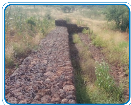
Figure 3 : Vue d'un seuil d'épandage
