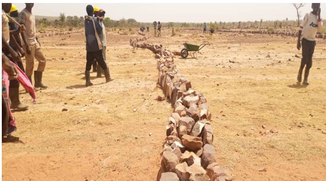
Figure 1 : Installation des cordons pierreux par les producteurs de la commune de Kendié.
